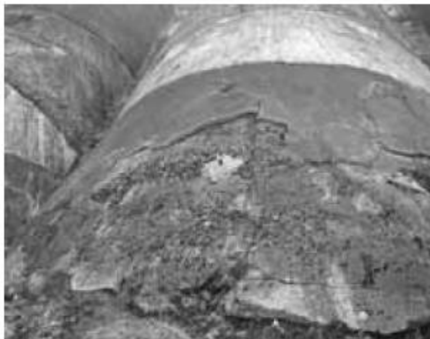
Dettagli delle volte della diga del Gleno; si nota il rivestimento esterno.
