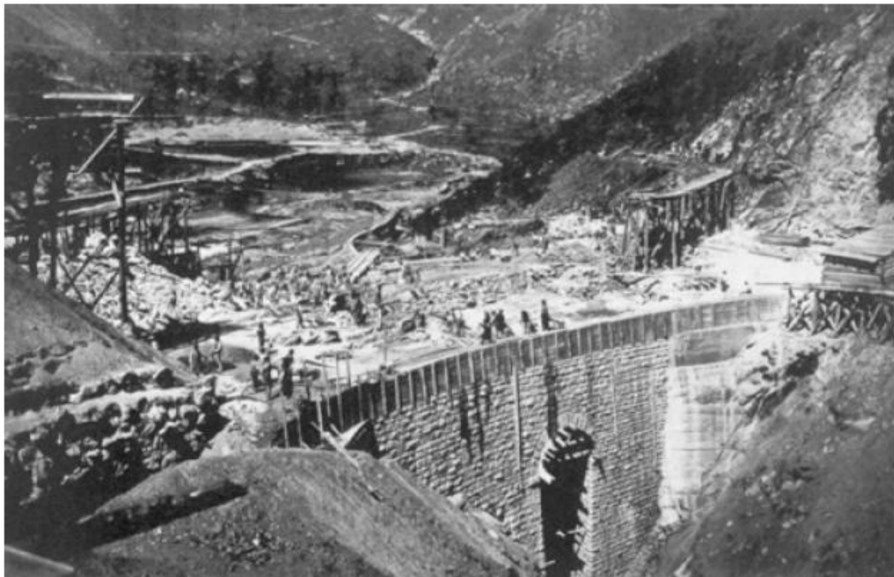
Completamento della diga inferiore a gravità, si nota il canale di scarico di fondo con struttura superiore ad volta lapidea (fgvb).
