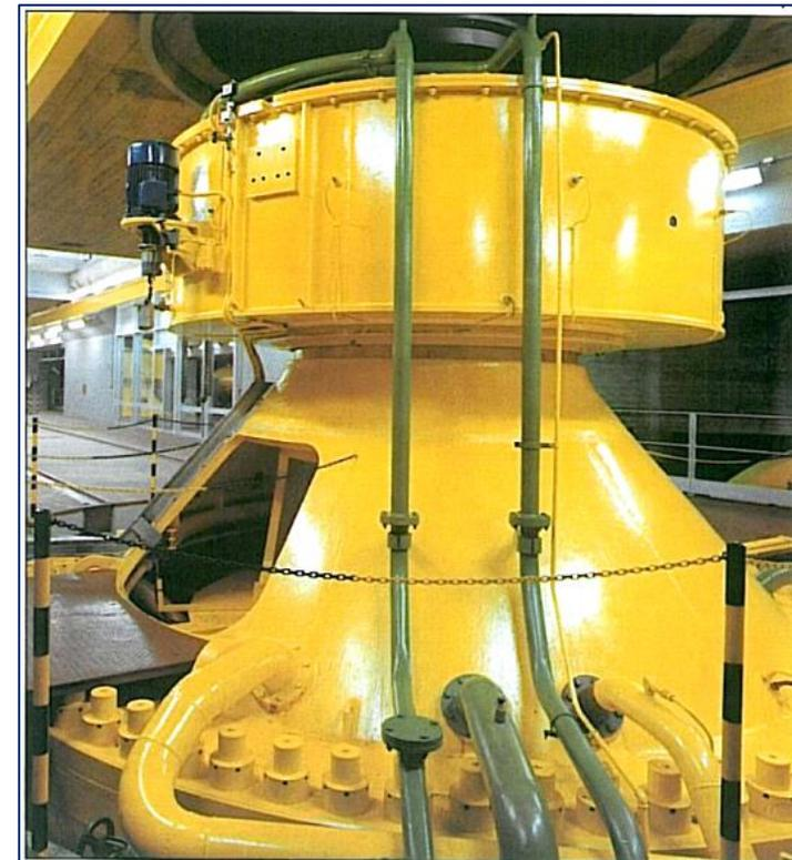
Supporto combinato di guida e spinta da 900 t. Raffreddato con serpentine d'acqua immerse in olio. E' prevista iniezione d'olio in pressione sui pattini alla partenza.
