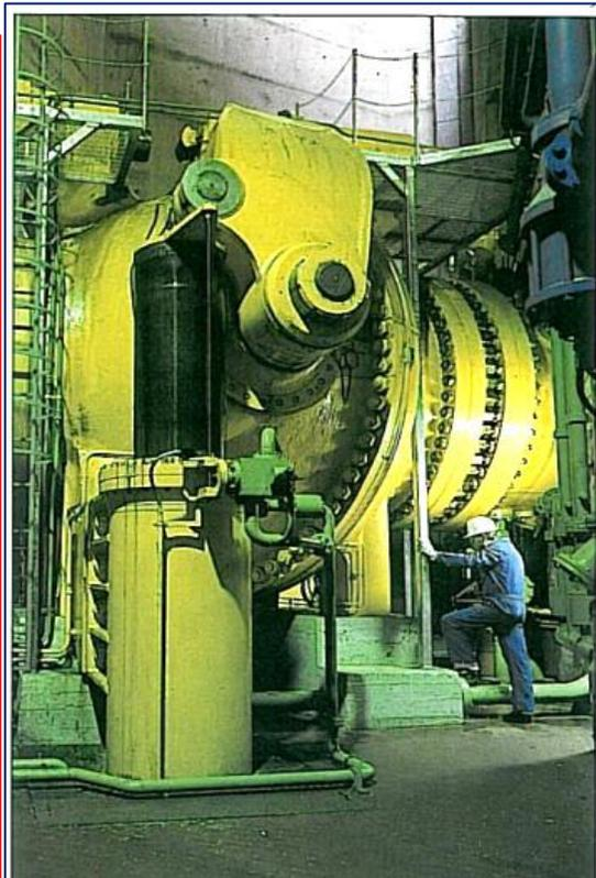
Valvola Rotativa di guardia a doppia tenuta: DN 2,3 m; PN 45 bar; peso 100 t. azionata dall'acqua condotta. Dotata di By-pass per avviamento.
